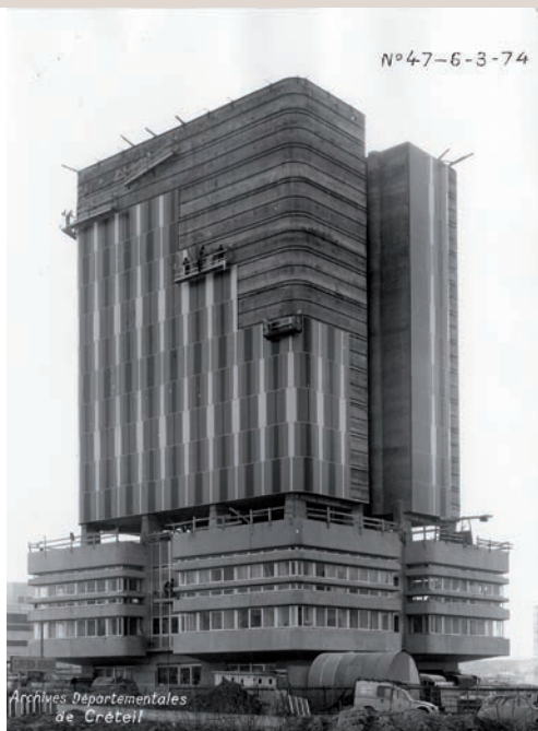
Archives départementales en cours de construction. Mars 1974. © H. Fernier. Archives départementales du Val-de-Marne, 45 W 53.
