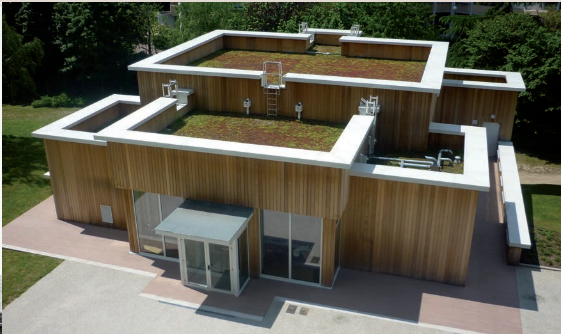
Pavillon des Archives et sa toiture végétalisée. Mars 2012. © Conseil général du Val-de-Marne.
