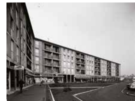
« La pierre aux Prêtres », centre commercial de la Cité à Orly. 1965 (©Beranger / AD94)
